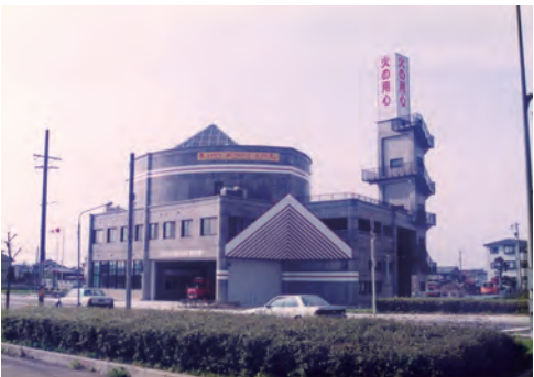
交通の要所に建てられた南分署（平成 10 年）
