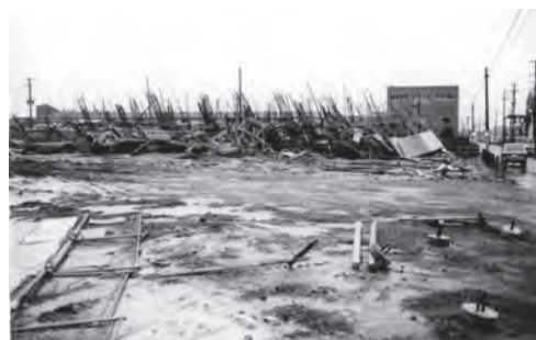
建設途中の大治西小学校
