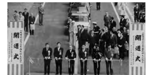
国道302号西北部大治地区開通式（平成3年3月）
