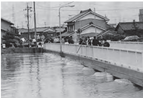
橋桁のすぐ下に迫る水（新川・砂子橋）
