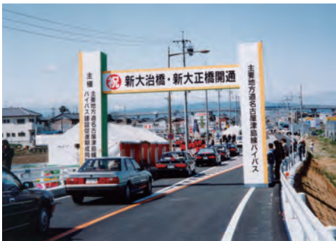
新大正橋の渡り初めの車列（平成 5 年 3 月）
