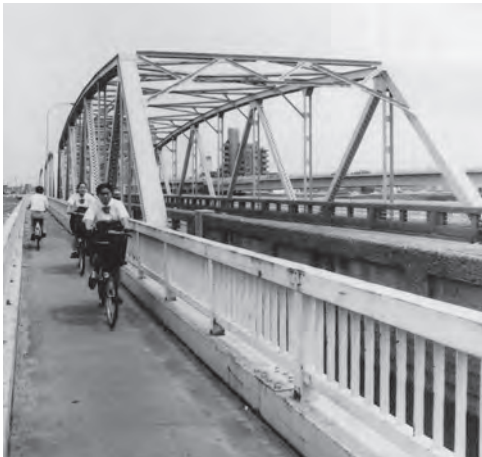
架け替えられる前の大正橋（平成 6 年）
