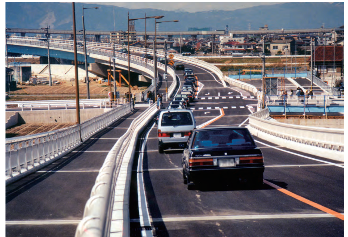
町の大動脈、名古屋津島線バイパス新大治橋・新大正橋の開通（平成 5 年）
