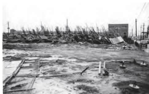
建設途中の大治西小学校
