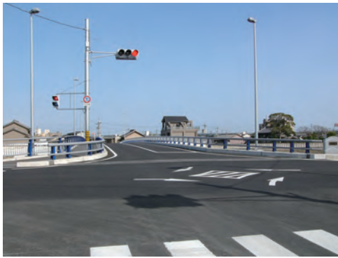
架け替えられた砂子橋（平成 19 年）
