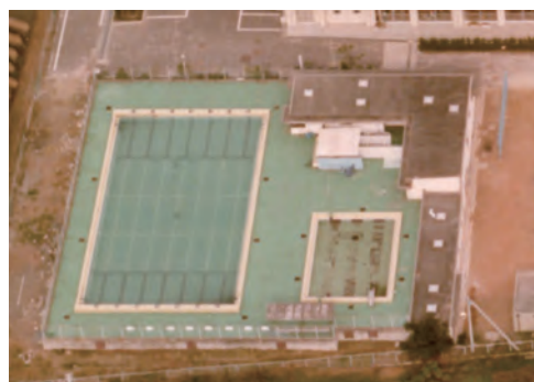
身長や泳力に合わせて、2つのプールで水泳授業（大治南小学校、昭和57年）
