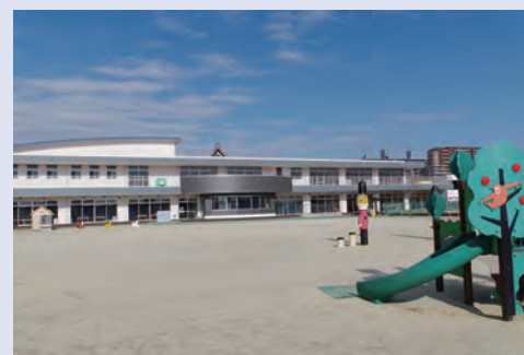
新築された園舎（令和6年）
