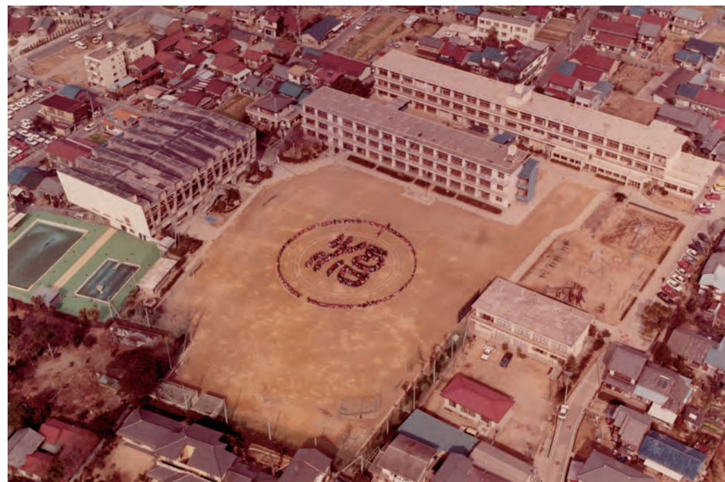
大治小学校航空写真（昭和 61 年）
