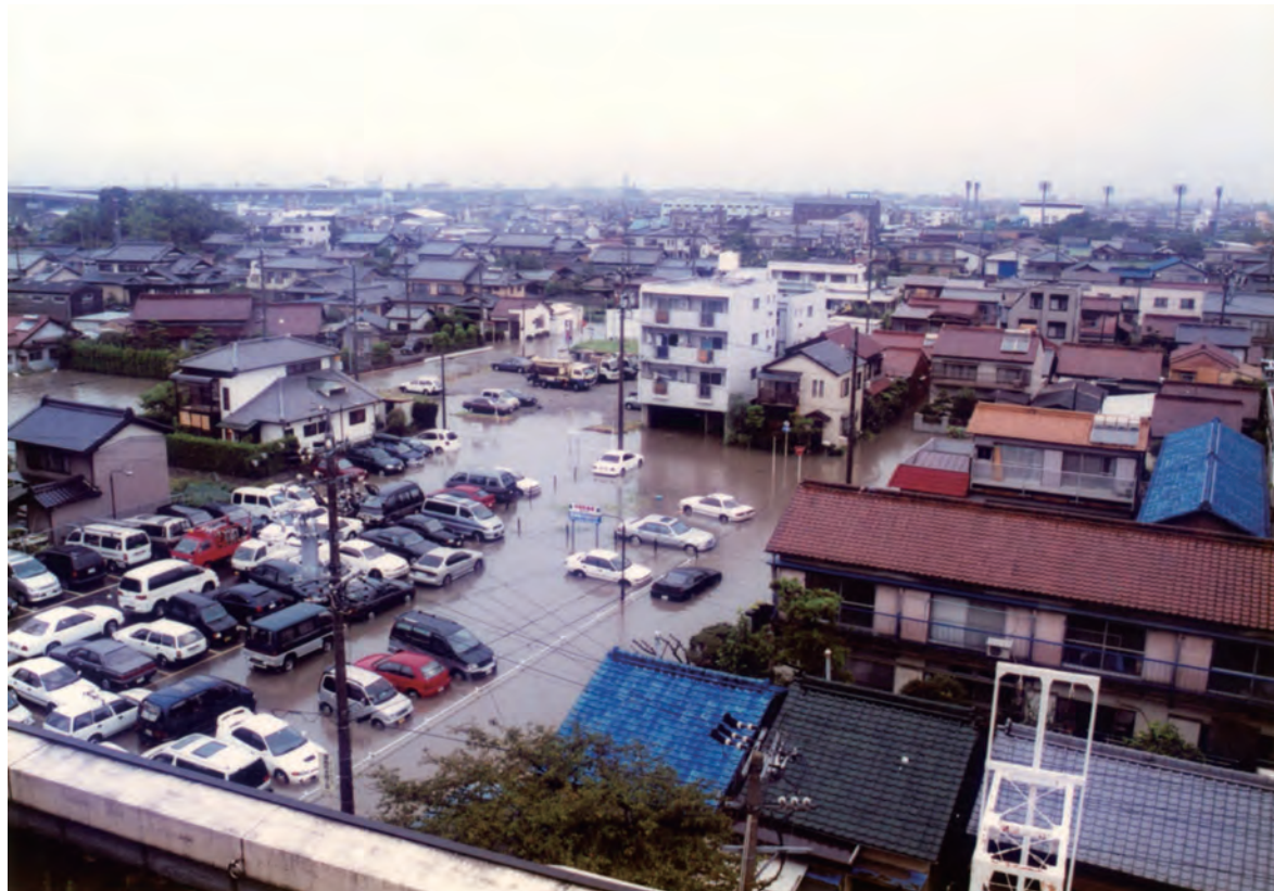
町に甚大な被害を及ぼした東海豪雨（平成 12 年）
