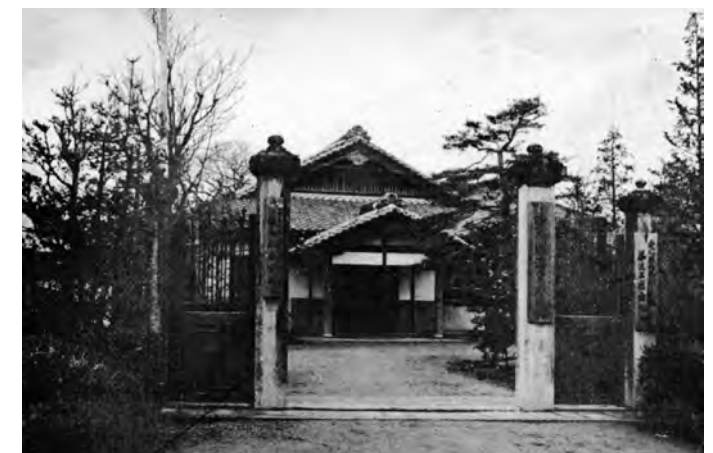
海東郡役所（明治37年）
