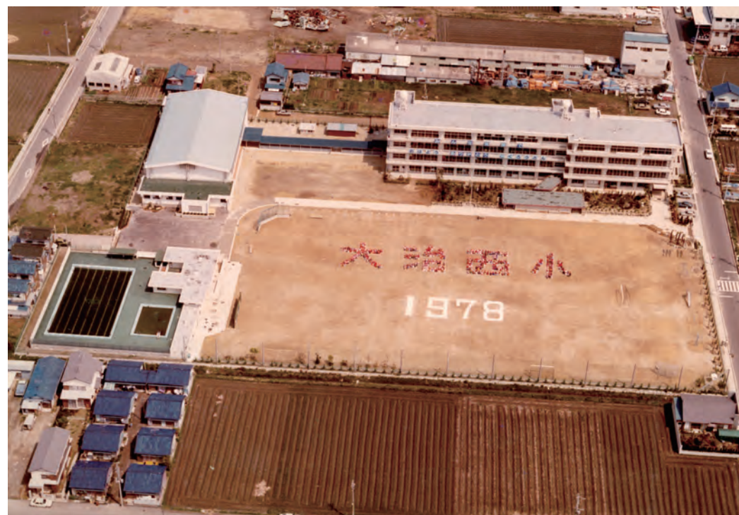
校舎の増築前で、体育館との間に長い渡り廊下がありました（昭和53年）
