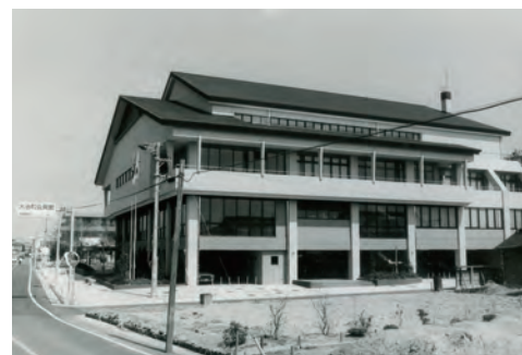
完成した大治町立公民館（昭和55年）
