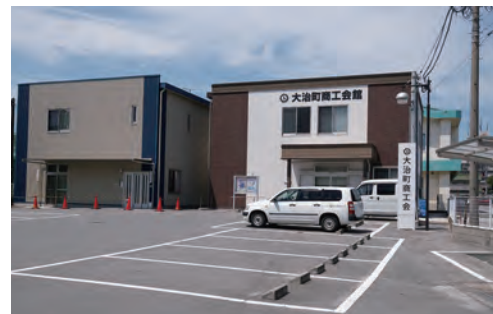
新築された大治町商工会館(令和6年)
