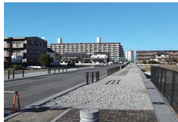
都市計画道路 堀之内砂子線の工事の様子
