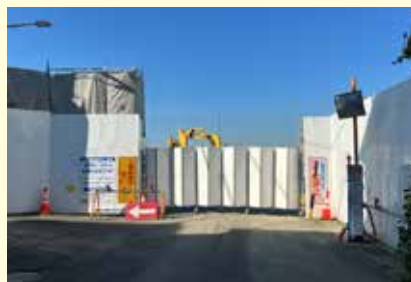
改修工事現場
