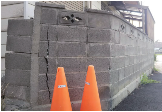
亀裂が入ったブロック塀 (現在は撤去済み)
