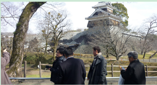
激しいゆれを物語る 崩壊した石垣
