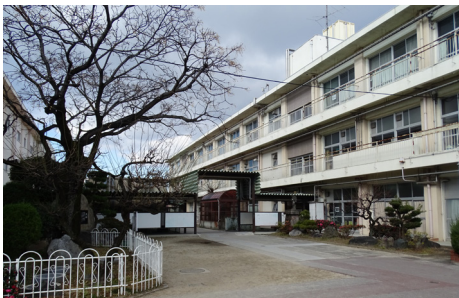
改修を待つ大治小学校
