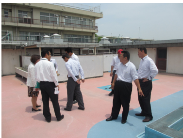
南小学校プール改修工事
