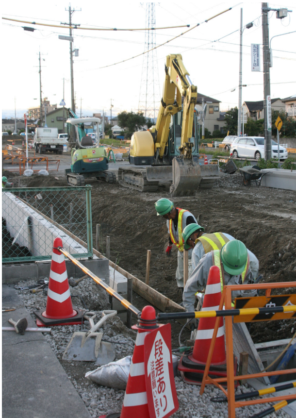
バイパス線 工事進行中
