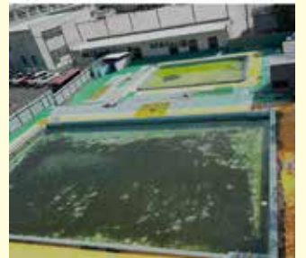
大治小学校のプールの現状
