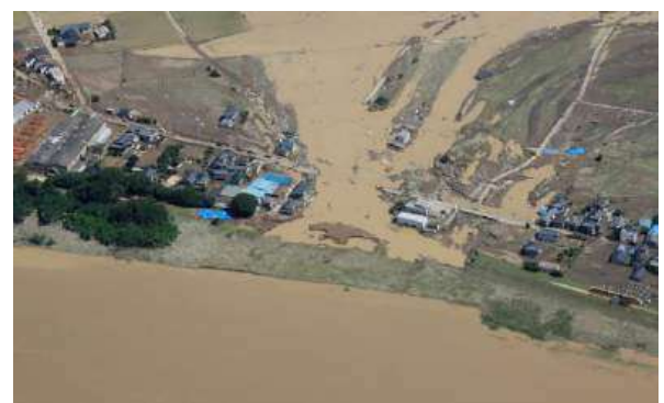
堤防決壊による家屋の流失(鬼怒川)
