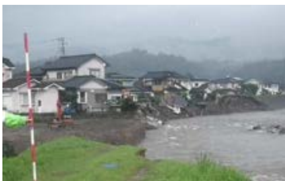
河岸侵食による家屋の倒壊(花月川)
