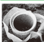
浸透ますは、壁面から雨水を地下にしみこませることができます。
