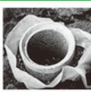
浸透ますは、壁面から雨水を地下にしみこませることができます。
