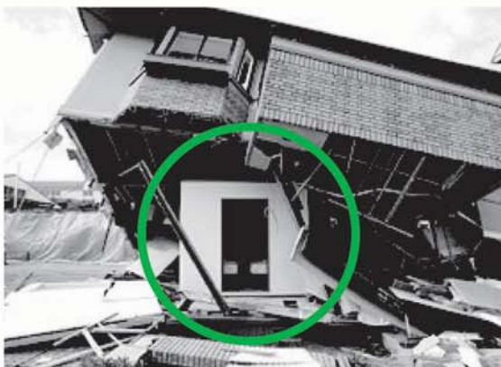
▲耐震シエルターの一例
