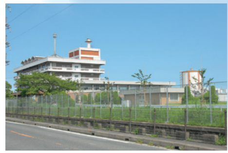
大治浄水場 Oharu Water Plant
