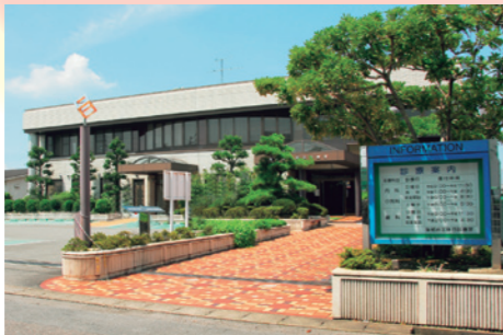
海部地区急病診療所(津島市) Ama Area Emergency Clinic
