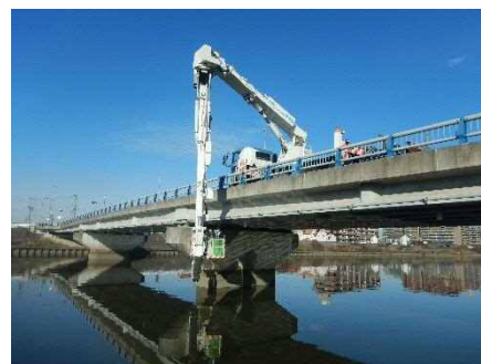
写真 橋梁点検状況 (橋梁点検車)
