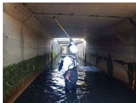
写真 橋梁点検状況 (地上)
