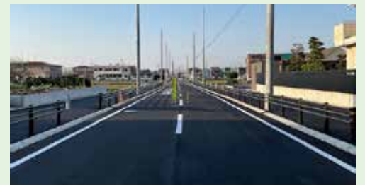
整備が進む堀之内・砂子線
